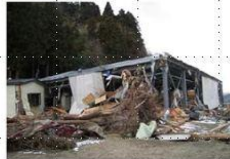
<宮城県 北上ビル>
